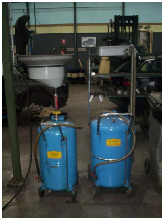
Voorbeeld van aftapunits voor systeemvloeistoffen zoals geïnstalleerd bij Autobedrijf De Jonghe (Deurne)
